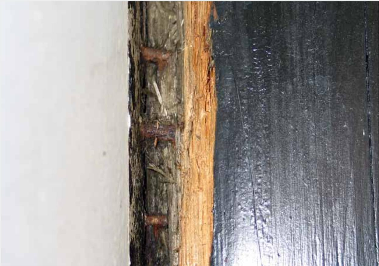
Fäulnis entlang den vertikalen Fugen zwischen Trapez und Ständer, die Nagelung wird sichtbar
