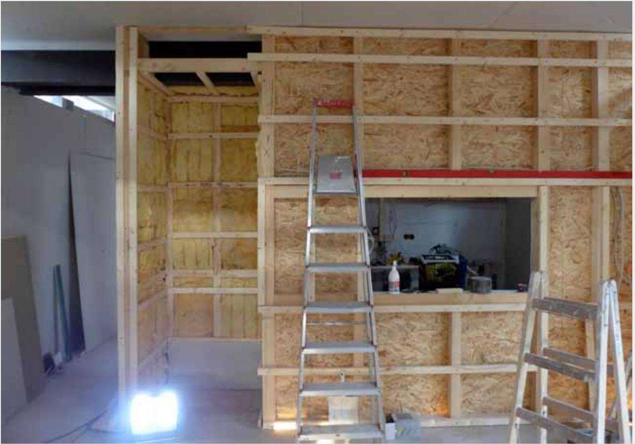
Die Küchenwand wird erneuert, das stabile Holzgerüst verstärkt die Querversteifung des Hauses
