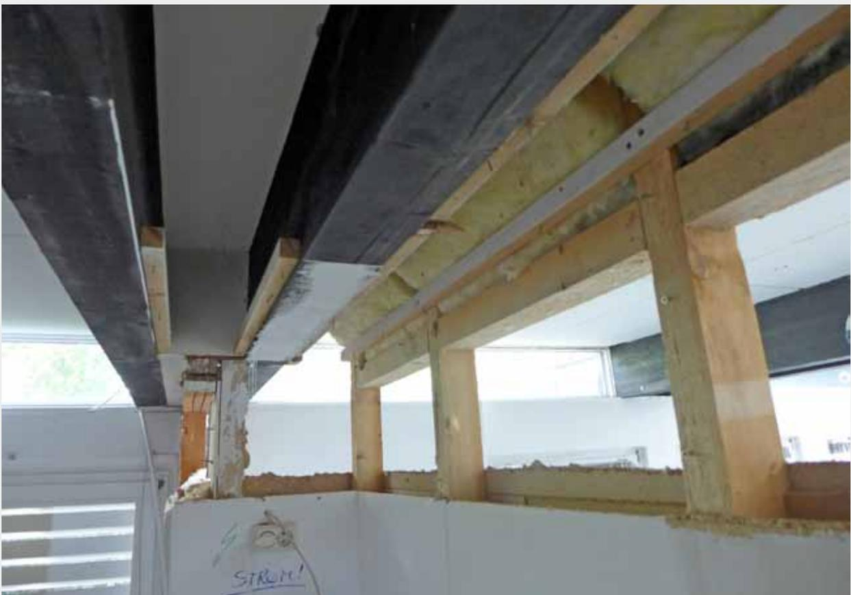
Die Innenwände werden z.T. um etwa 30 bis 40 cm gekürzt
