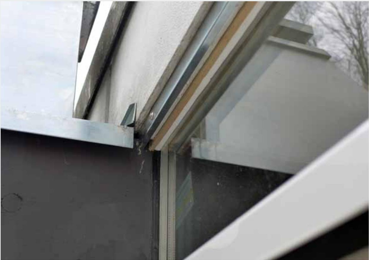
Von oben schützen Zinkprofile die Konstruktion
