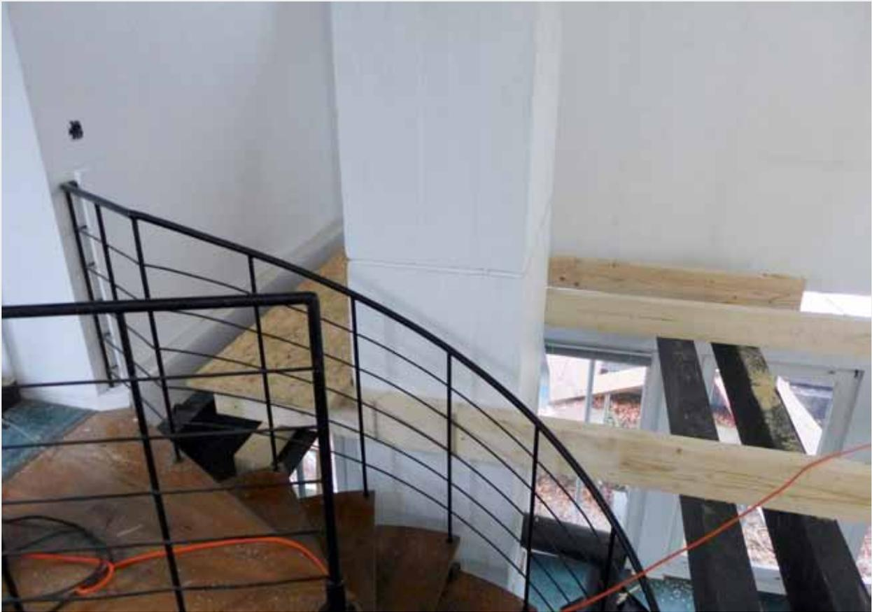
Die Abstützung im offenen Bereich erfolgt mit Hilfe quer eingelegter Tragbalken
