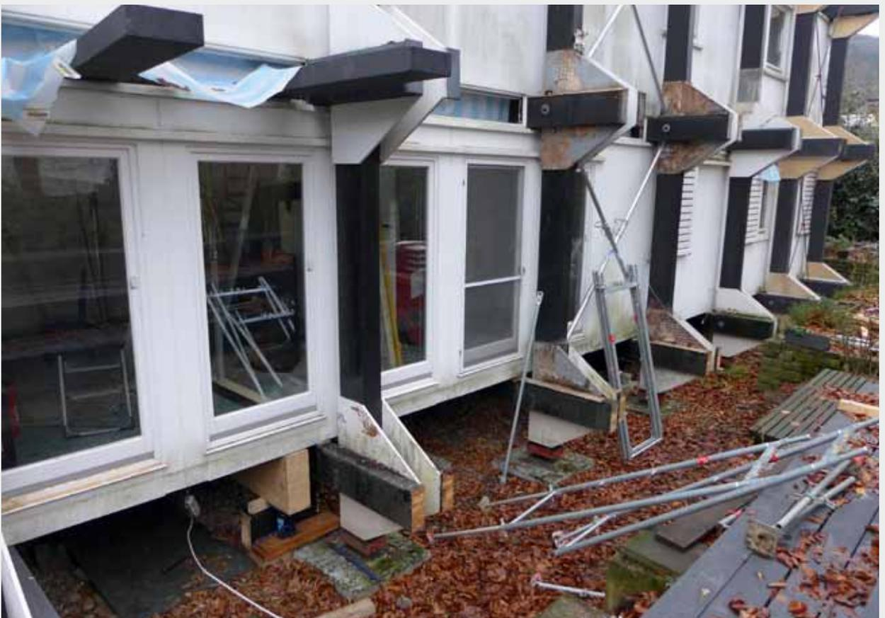
Die provisorische Aussteifung wird zur weiteren Stabilisierung versetzt
