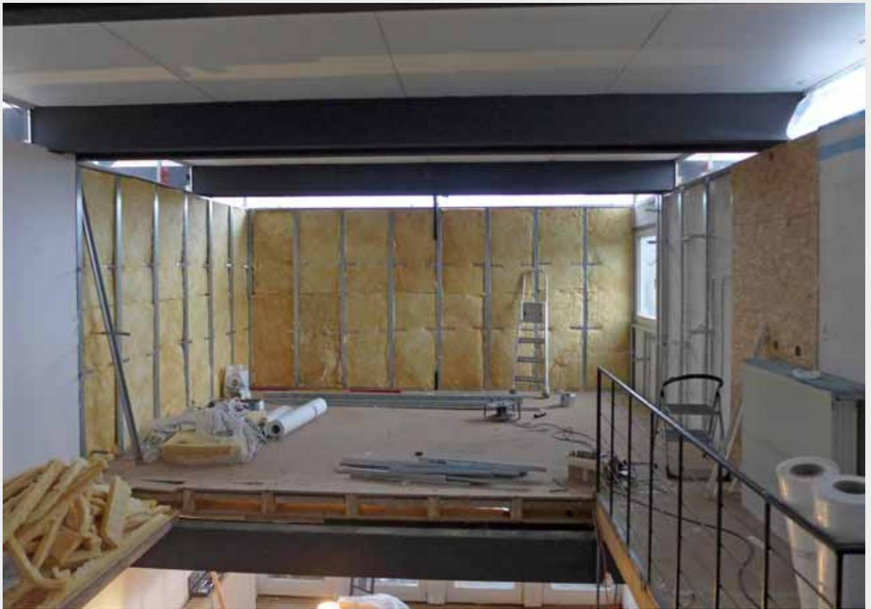
Die Innenwände werden wiederhergestellt und in der Isolierung verstärkt
