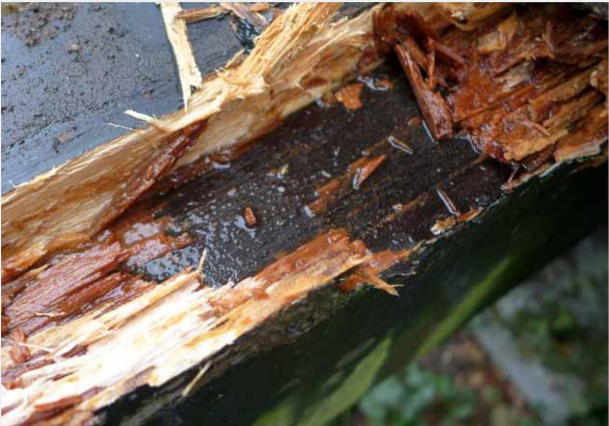
Die Träger der Terrasse sind extrem feucht. Hier steht Wasser auf dem Leim der zweiten Binder-Schicht
