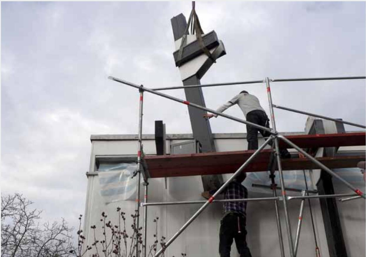
Ein abgesägter Ständer wird mit dem Kran abgehoben
