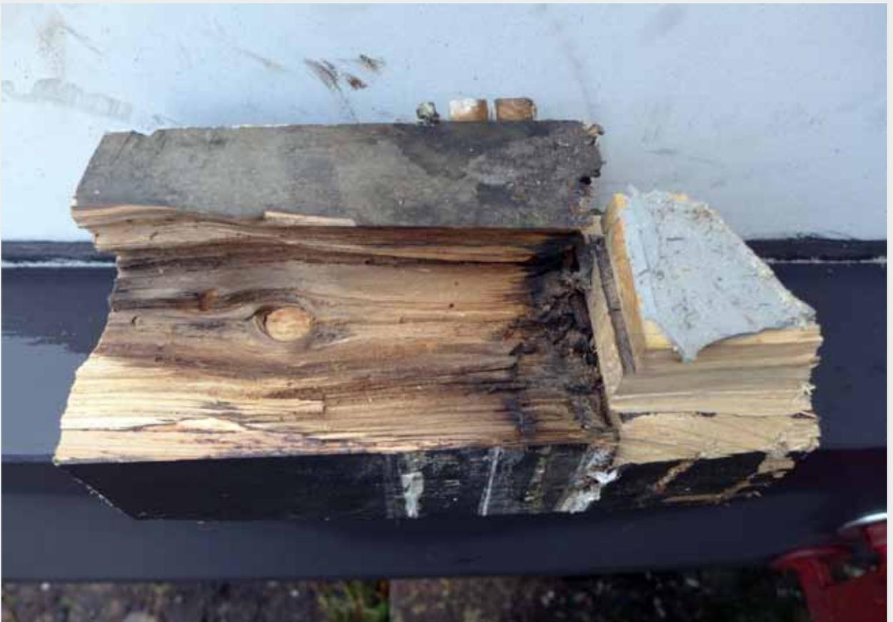
Dieser Balkenkopf wurde 1993/94 erneuert, allerdings fast glatt angefügt, damit statisch nicht belastbar
