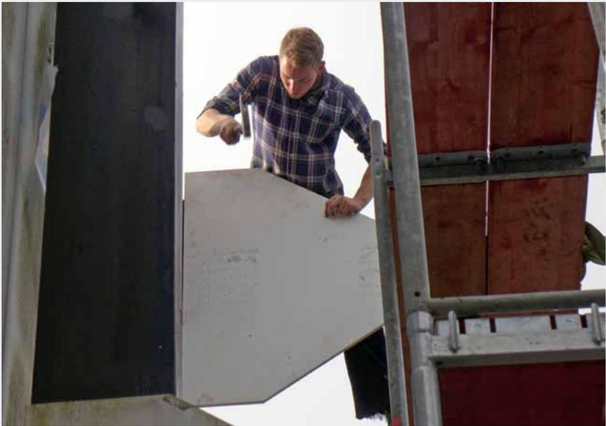
Die Edelstahl-Nägeln werden mit wenigen Schlägen vernagelt, sie werden schnell weich und verbiegen
