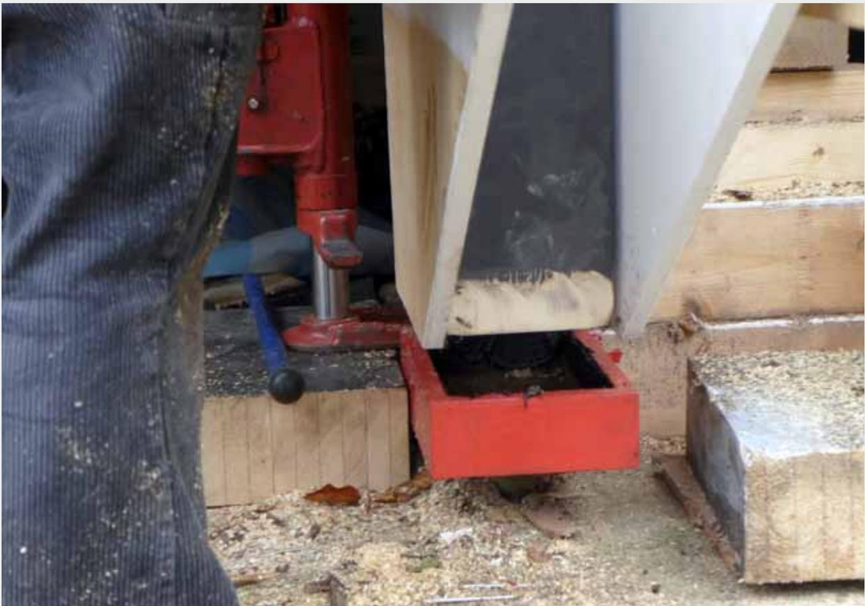
und in die mit Bitumen ausstrichenen Stahlschuhe eingefügt
