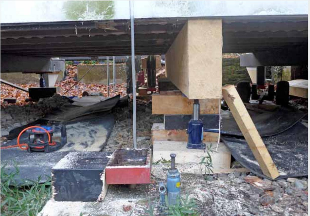
Das Haus wird mit hydraulischen Hebern ca. 1-2 cm angehoben, um Setzungen auszugleichen
