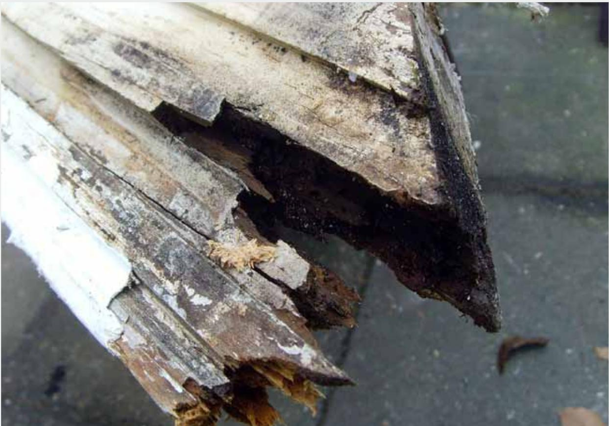
An den Hausecken drang durch die Fugen weitere Feuchtigkeit in die Fensterbänke ein
