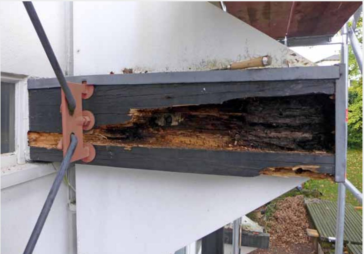
Schäden an einem gartenseitigen Träger der mittleren Reihe
