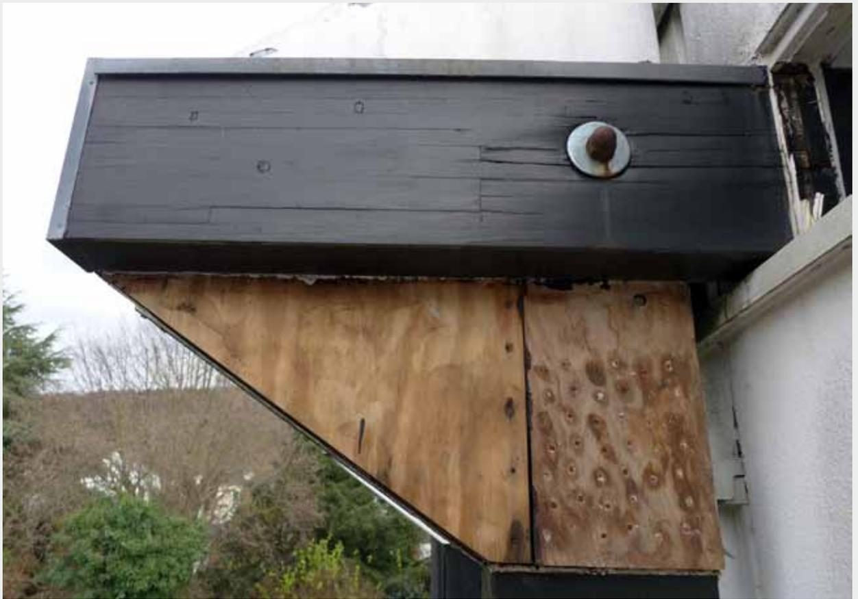
Bei den Reparaturen 1993/94 wurde das statische Prinzip außer Acht gelassen, so wurde hier ein Teil
