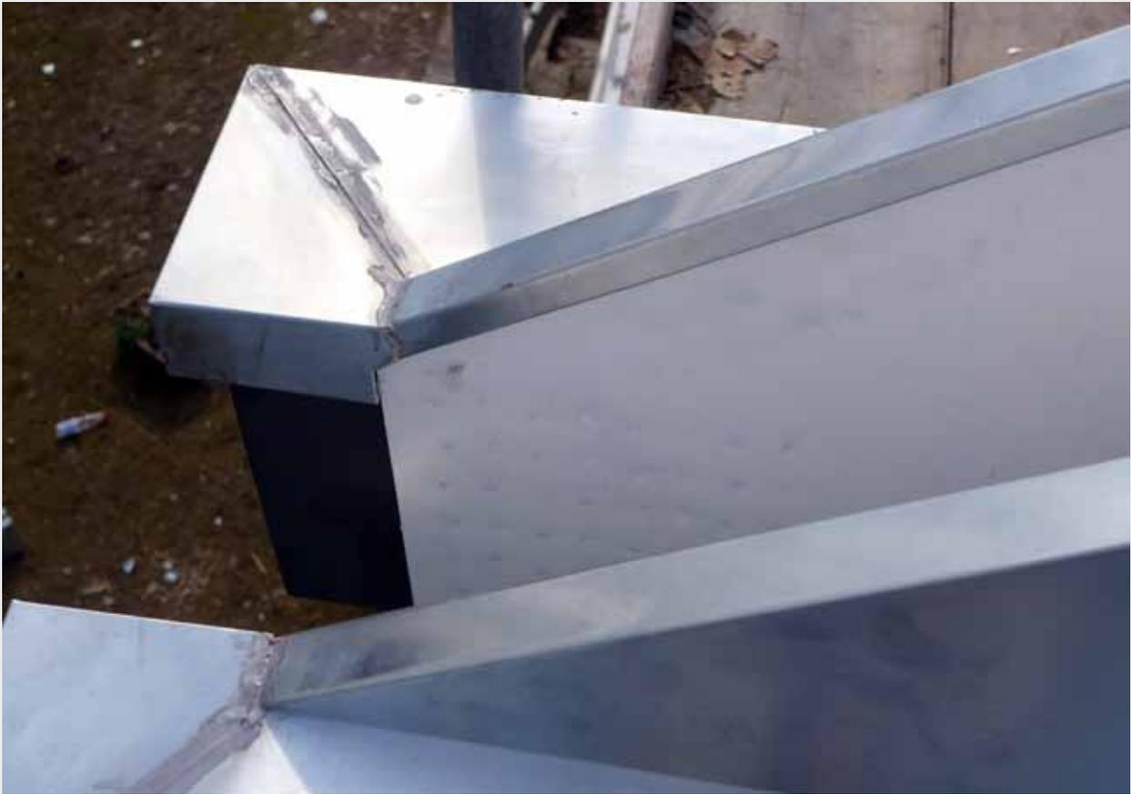
Das Regenwasser wird über breite Blechkanten abgeleitet
