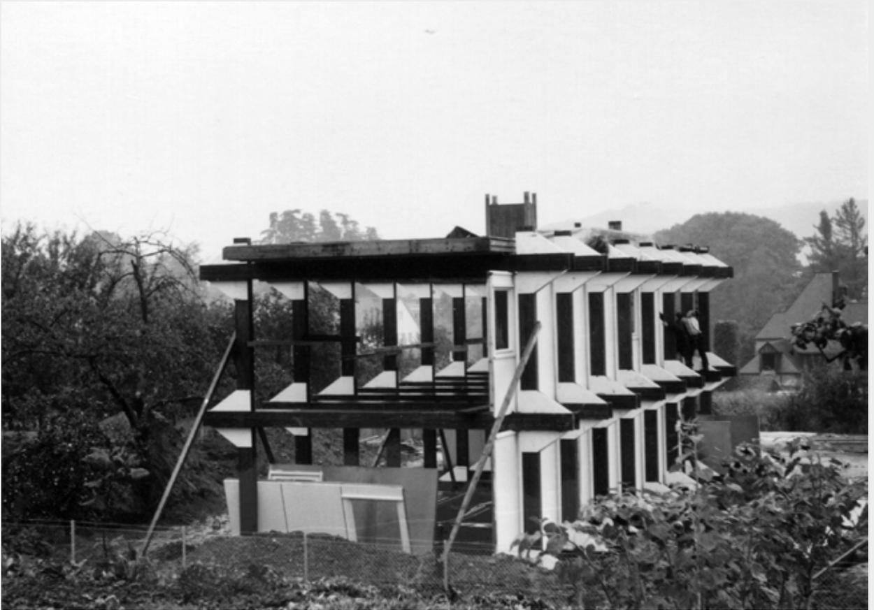
Bauphasen Juli 1967, Montage der Decken und Außenwände
