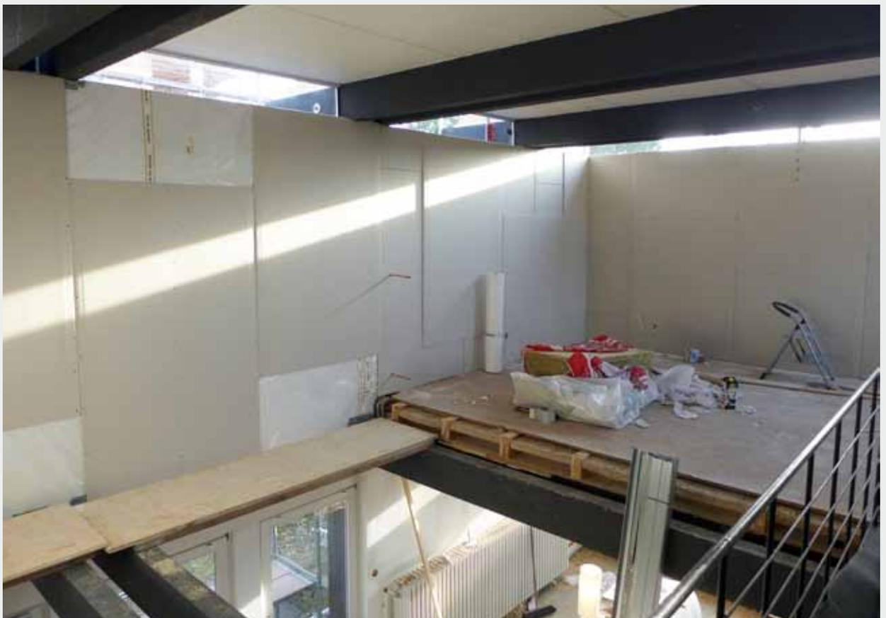
Alle Wände und die Decken im Untergeschoß werden mit Gipsplatten neu belegt
