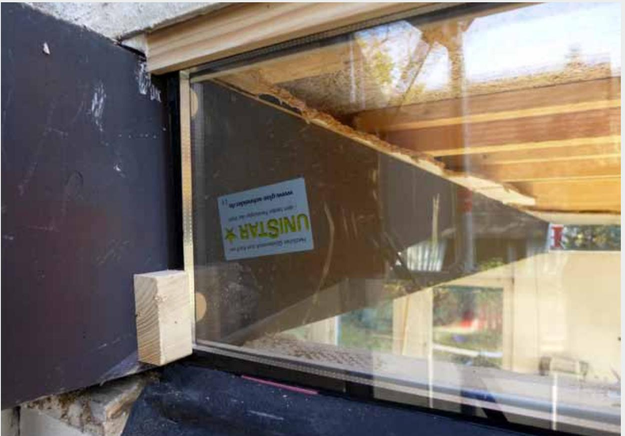
Beginn der Verglasung, zwischen Glas und Wand wird ein Dichtband gegen Kondensatbildung verlegt
