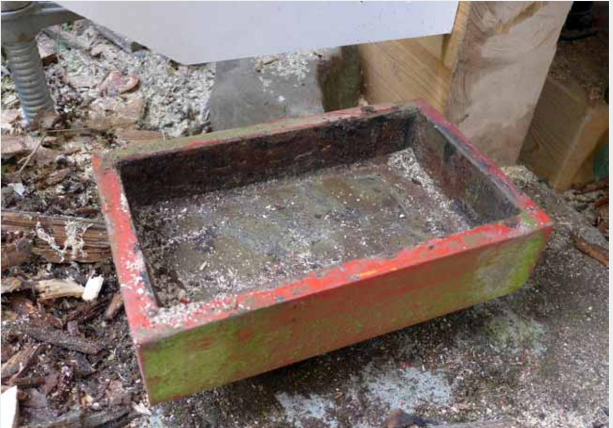
Die Stahlschuhe für die Ständer werden gereinigt
