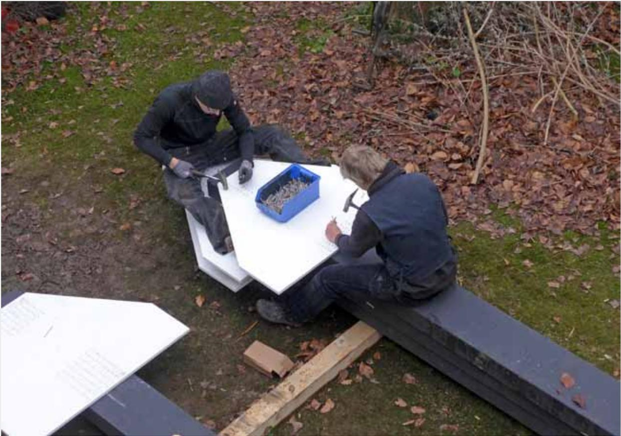
Die Schichtholzplatten werden einseitig an die Tragbalken genagelt, das Nagelbild ist exakt vorgegeben
