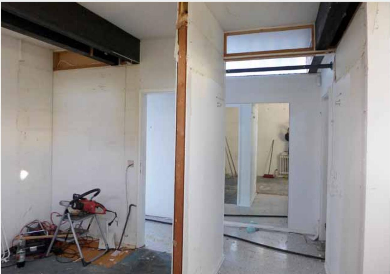
Für den Einbau der Abstützungen müssen einige Wände entfernt oder geöffnet werden
