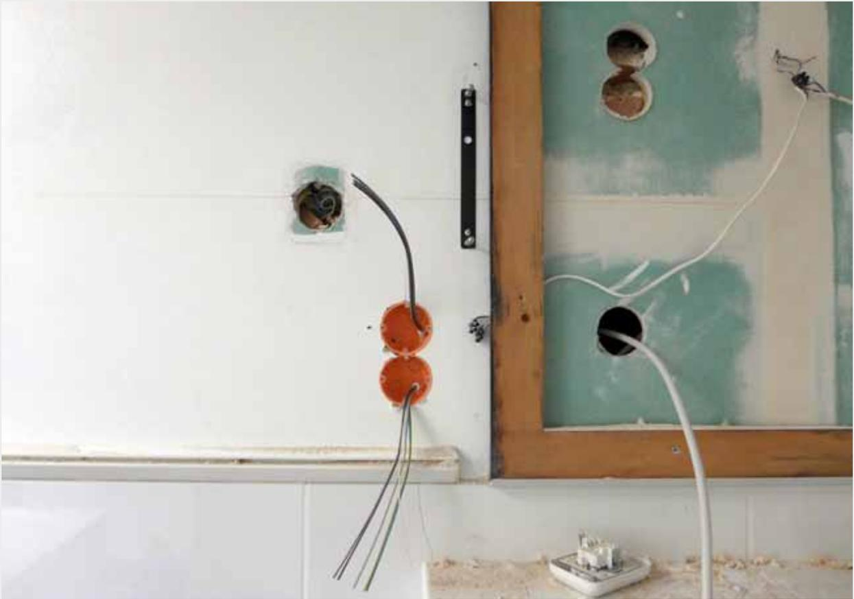
Die Elektrik wird wegen der starken Beschädigungen durch die Sanierung aus Sicherheitsgründen fast
