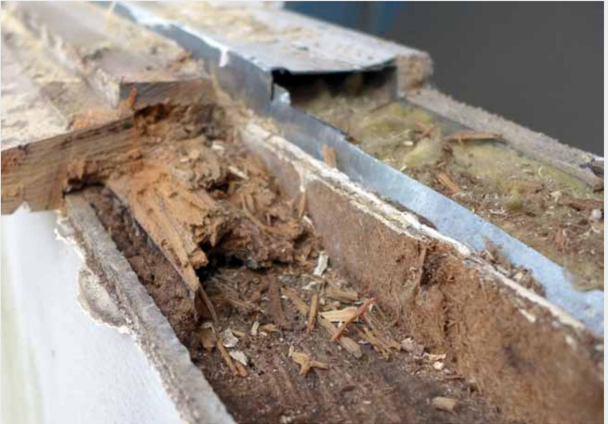
Sämtliche Fensterbänke und die sie tragenden Hölzer sind so geschädigt, daß sie ersetzt werden
