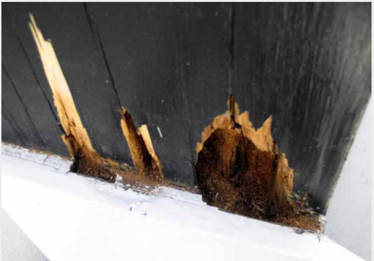
2006: erste Faulstellen, die mit einer Zweikomponenten-Füllung provisorisch verschlossen wurden
