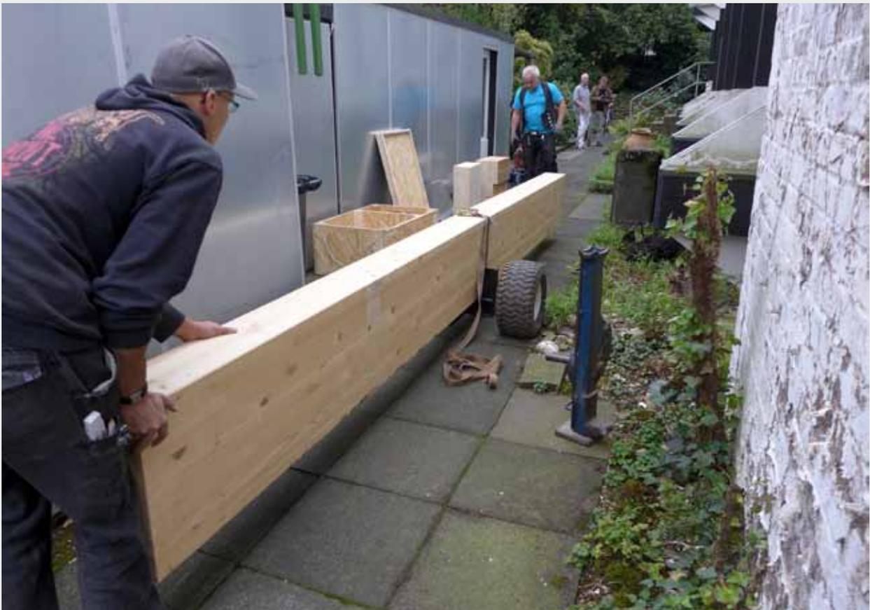
Zwei stark dimensionierte provisorische Träger werden unter dem Haus in Position gebracht
