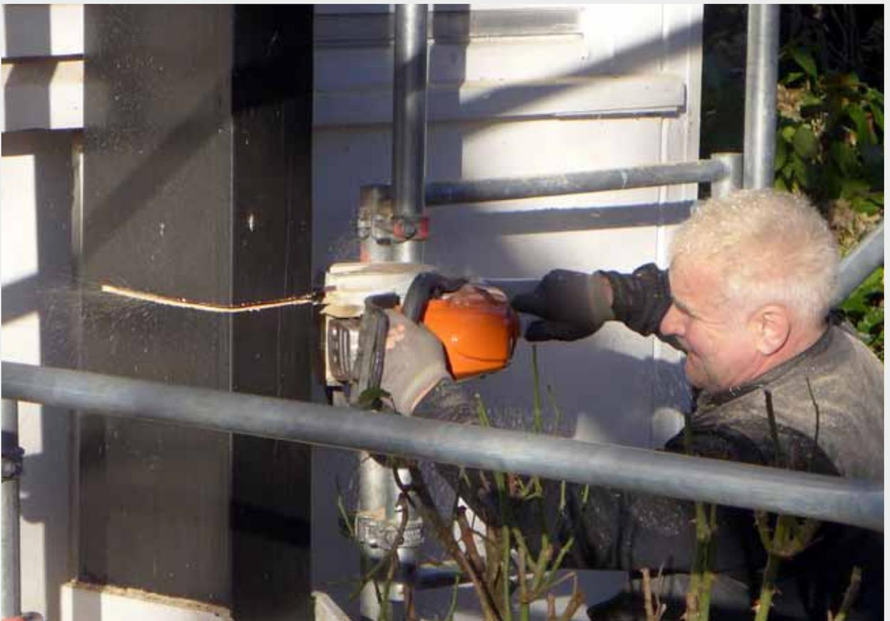
Nach der Abstützung und Sicherung kann ein Ständer zersägt werden
