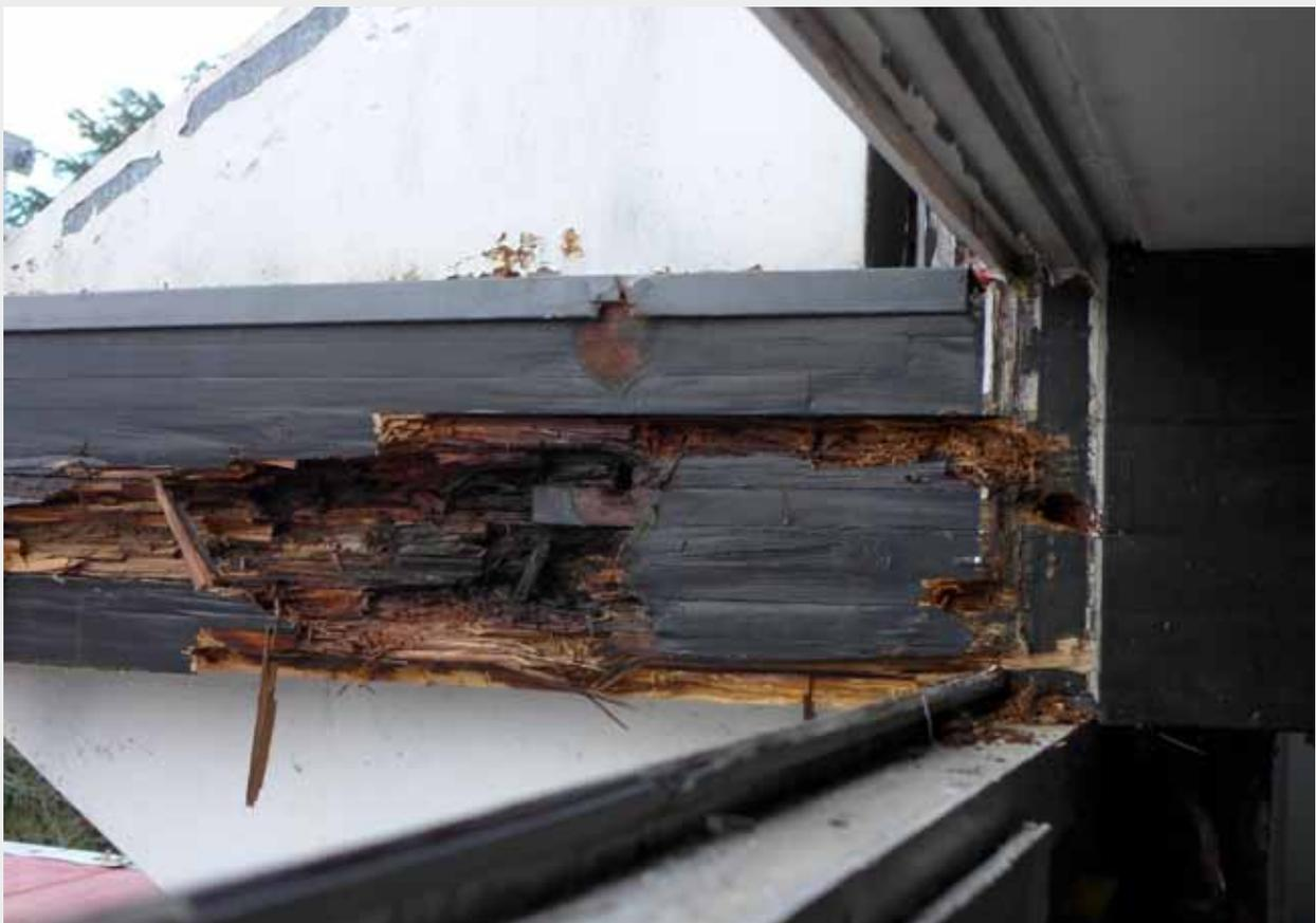
Die Tragbalken unter dem Dach sind im Außenbereich alle instabil bzw. teilweise in Auflösung
