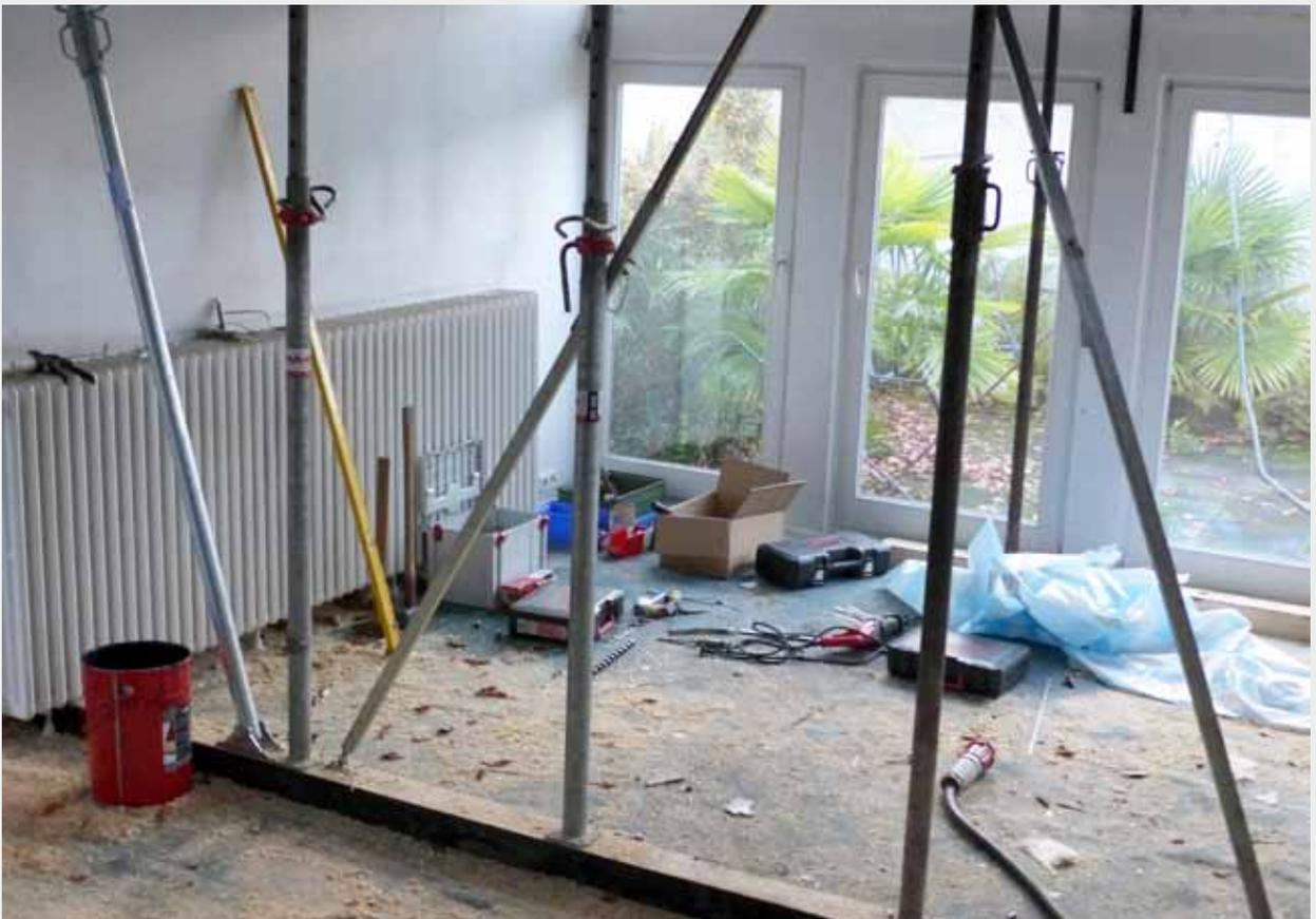
Innen wird die Abstützung bis unter das Dach fortgesetzt. Hier: Erdgeschoß
