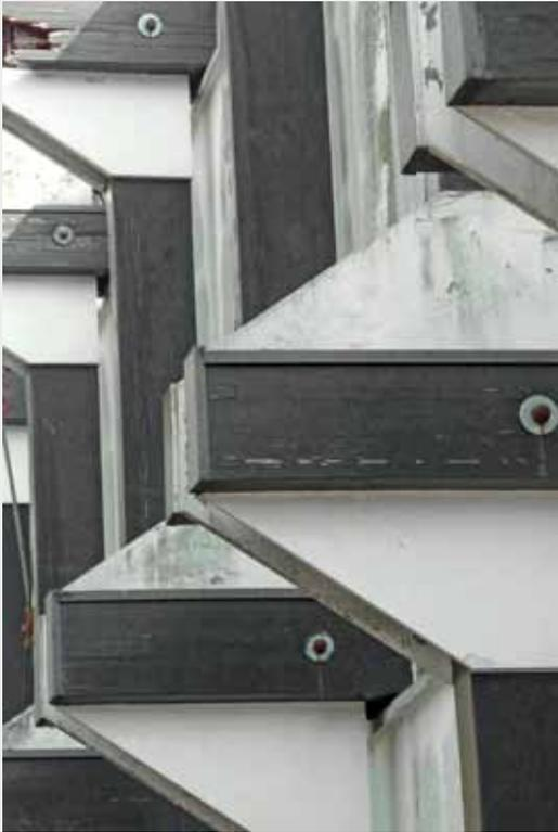
Das freistehende Tragwerk aus Leimbindern des „Hauses Mayer-Kuckuk“ war 1967 ohne jeden konstruktiven Holzschutz konzipiert und den Witterungseinflüssen ungeschützt ausgesetzt. Im Laufe der Jahre wurden die durch den fehlenden Schutz entstehenden Schäden immer massiver. Die fehlende konstruktive Sicherung der Kontaktflächen und Fugen zwischen Trägern / Ständern / Trapezen führte zu Fäulnis und Pilzbefall - vor allem an den nicht sichtbaren Flächen innerhalb der Konstruktion.
