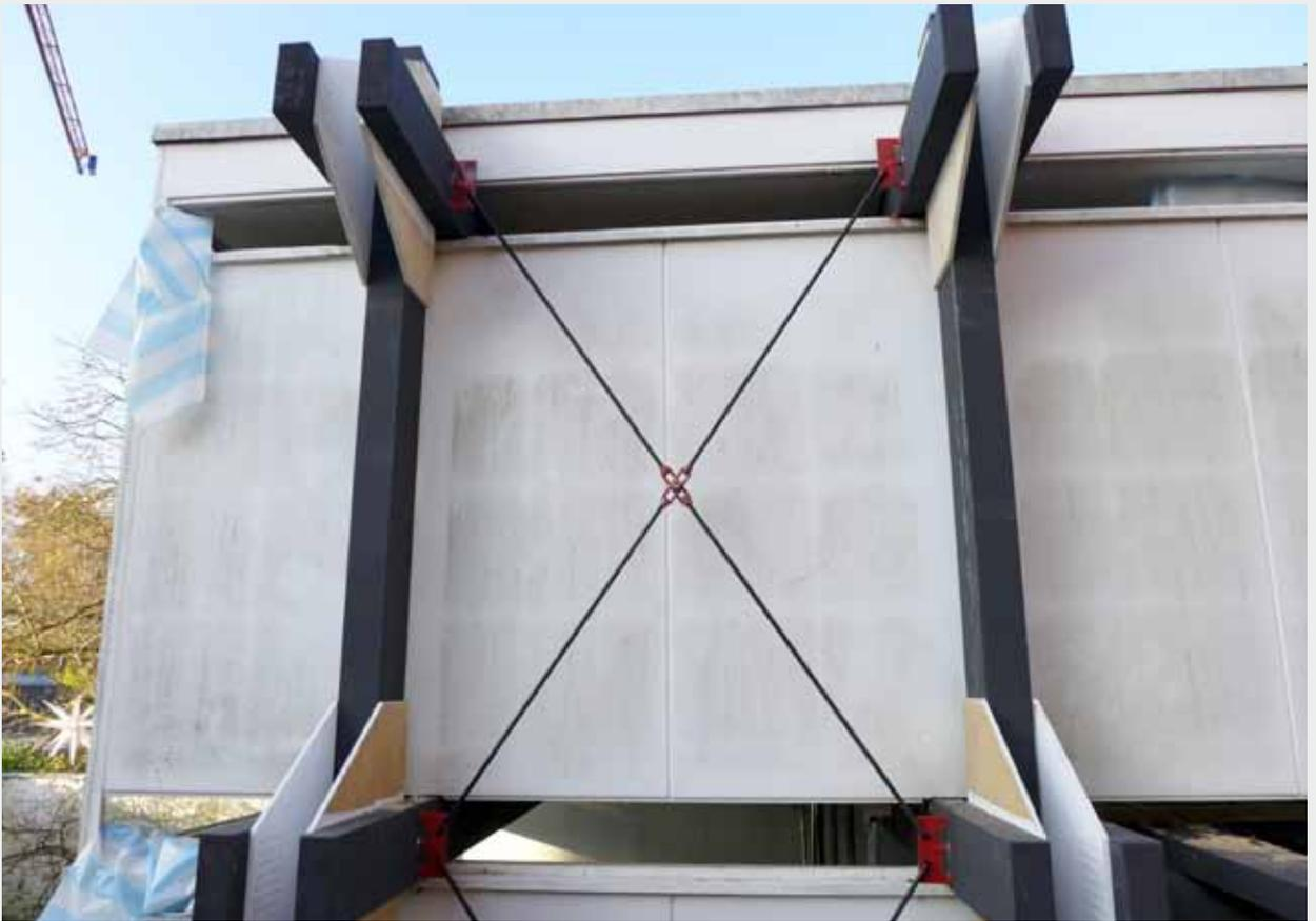
Nach dem Austausch der ersten Tragwerke wird die gereinigte Längsaussteifung wieder montiert
