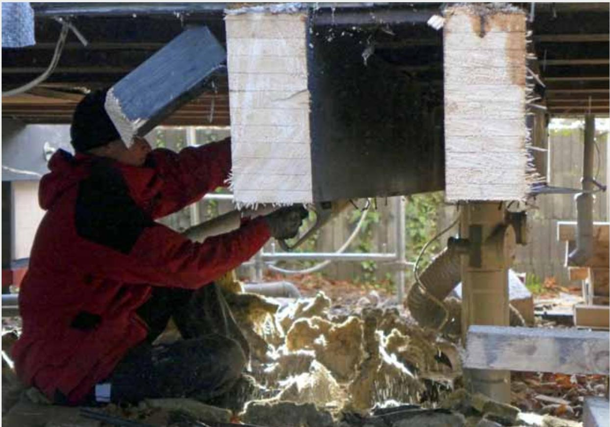
Die Tragbalken werden von den Böden und Decken getrennt, in Stücke zersägt und abgeräumt
