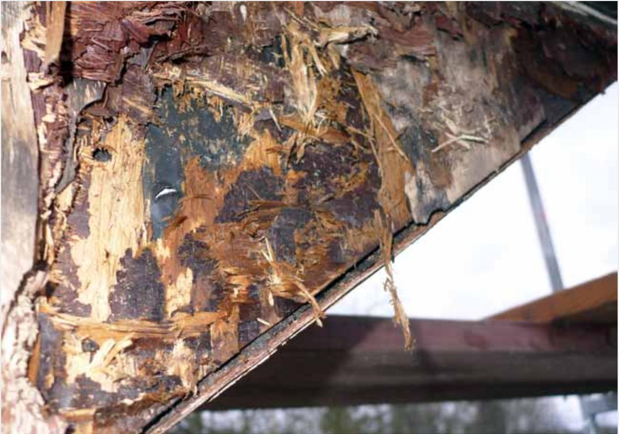
Die Mehrschicht-Holzplatten sind vor allem in den äußeren ein bis zwei Schichten geschädigt
