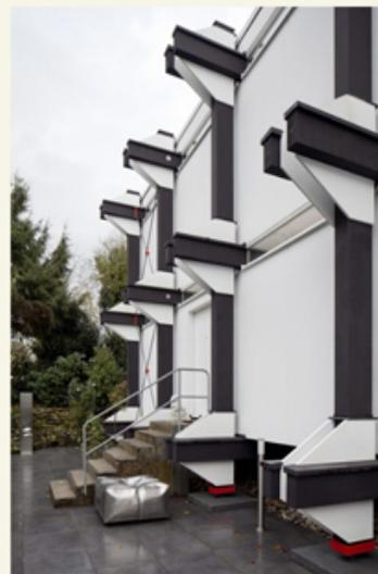
Nach schweren Holzschäden wurde – im Sinn des ursprünglichen Baugedankens – das Ständerwerk ausgetauscht (Bild: Hartmut Witte)
