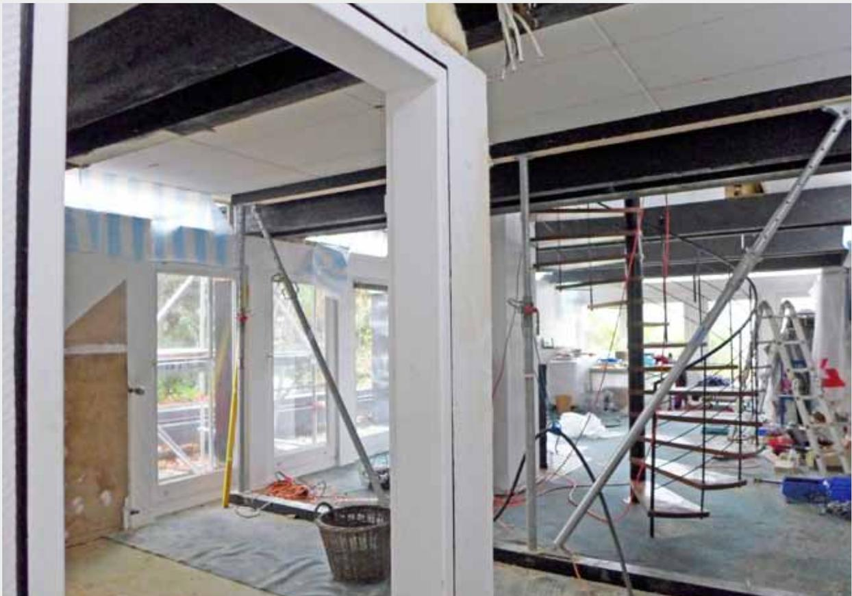
Die Küchenwand wird zur zusätzlichen Aussteifung entfernt und komplett neu gebaut,
