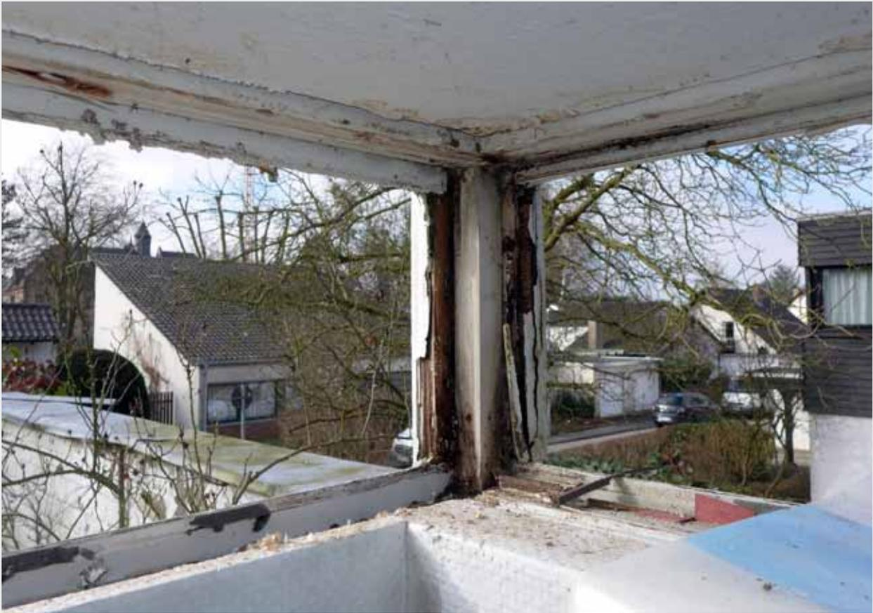
Für die Sanierung werden alle 48 Oberlichter ausgebaut, alle Scheiben wurden dabei zerstört
