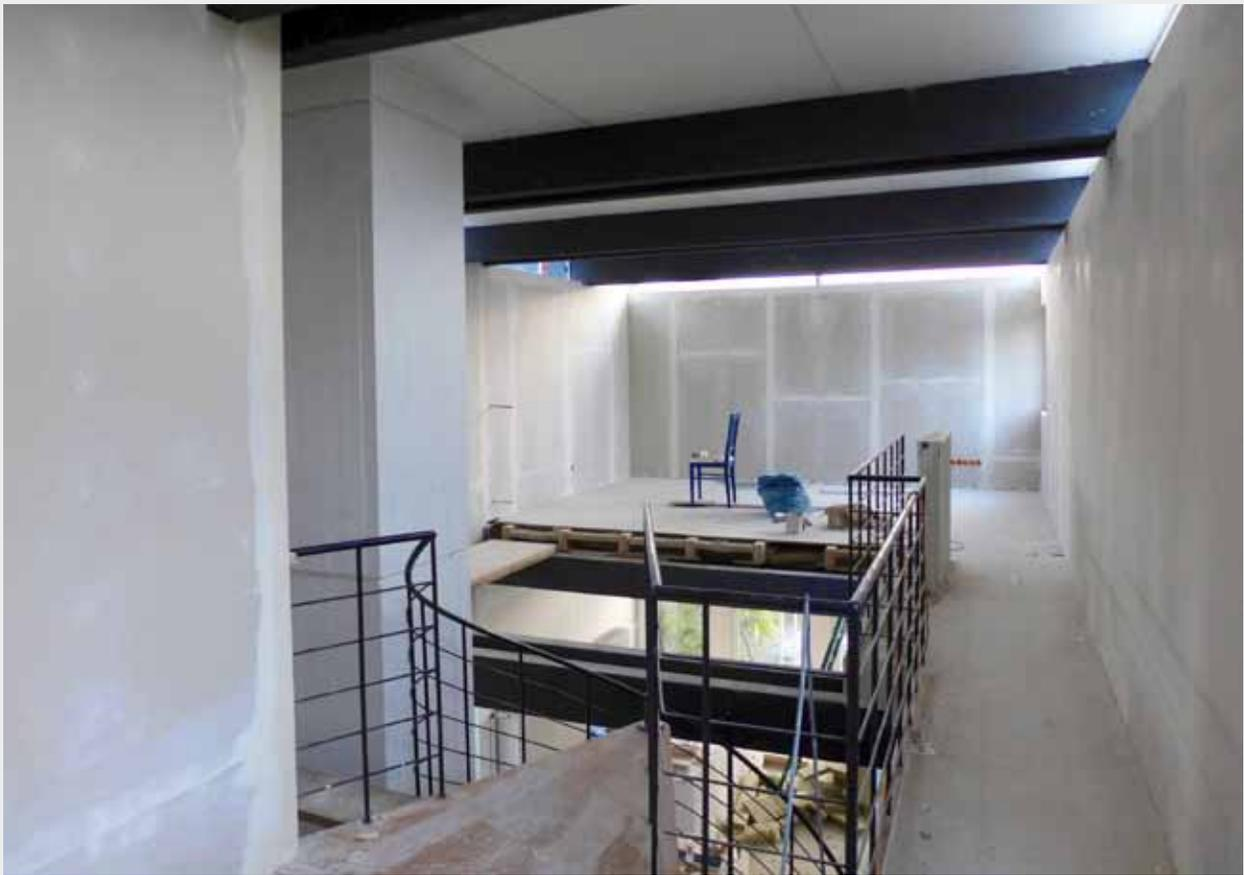
Die Wände werden geschliffen und mit einem Papiervlies belegt
