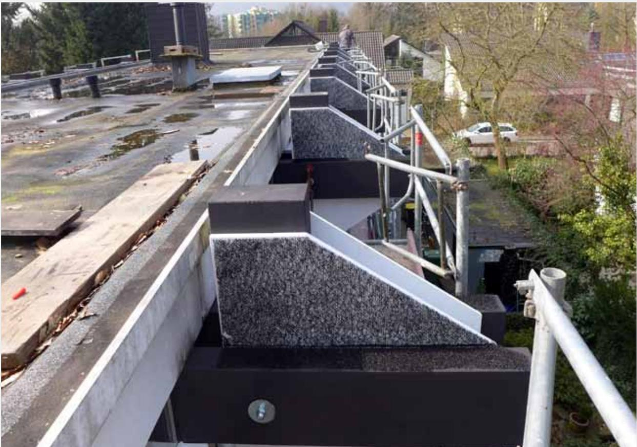
Die Zinkbleche zum Regenschutz der Tragwerke wurden vorgefertigt und werden montiert
